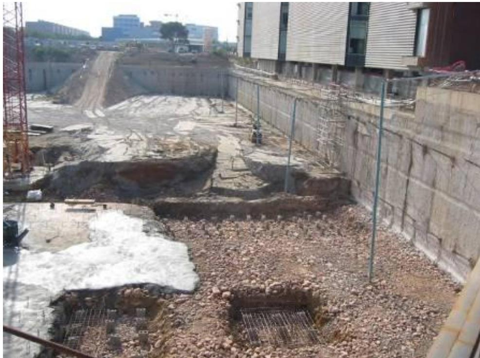
Figura 3.24.- Red de control con pozos de baja capacidad—Universidad Politécnica de Valencia—
