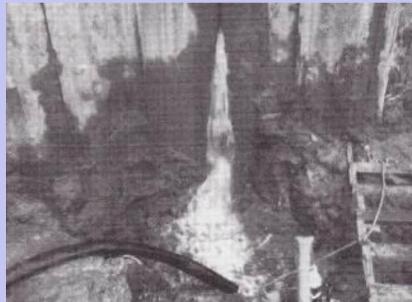
**Figura 2.20.-** Filtración lateral de agua a través de las planchas de un tablestacado
