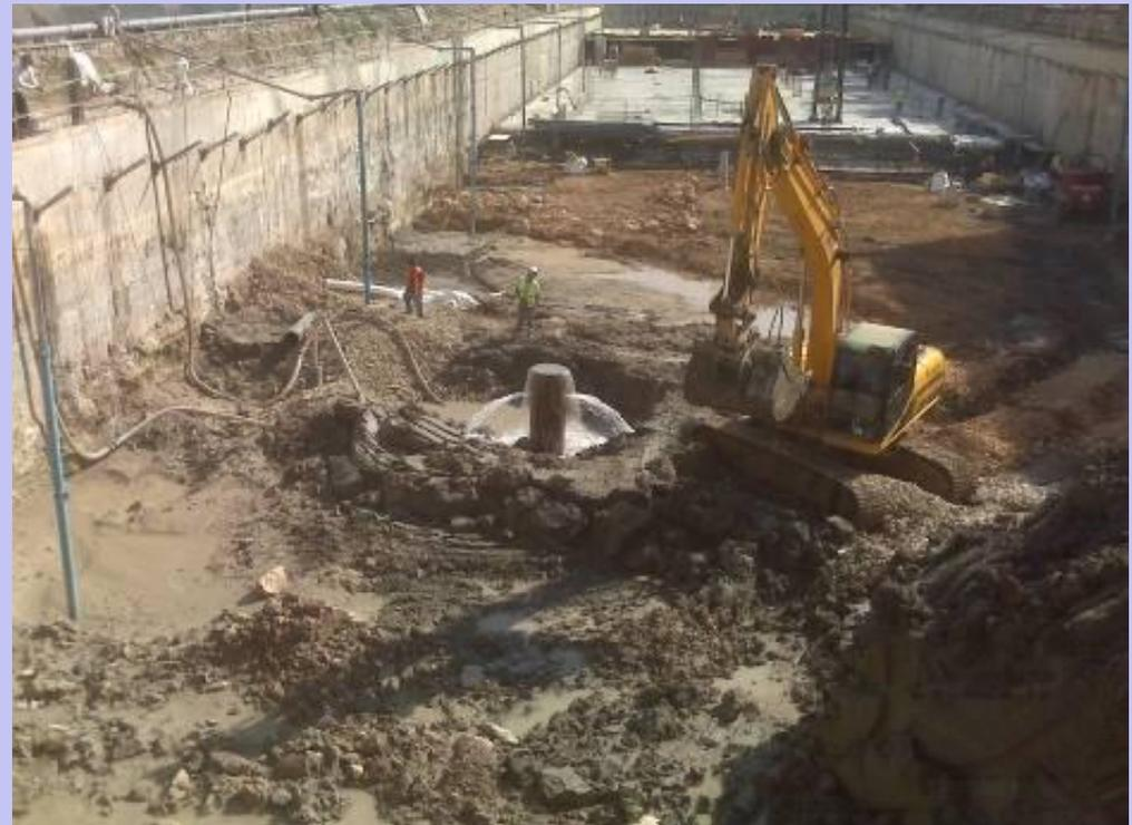
Figura 2.16.- Imagen general de surgencia en fondo de excavación drenada con pozos de baja capacidad. Valencia, 2009 (Cortesía de FERRER, S.L.).
