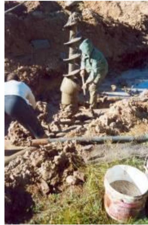
**Figura 3.14.-** Montaje de un filtro wellpoint. Izda. Asta helicoidal perforando con cabezal hidráulico.
