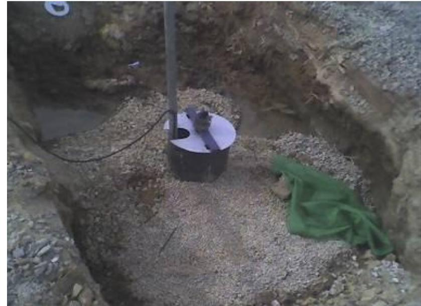
Figura 3.3.- Imagen de sumidero (*sump*) completamente equipado, previo a la ejecución de la excavación (cortesía de FERRER, S.L.).
