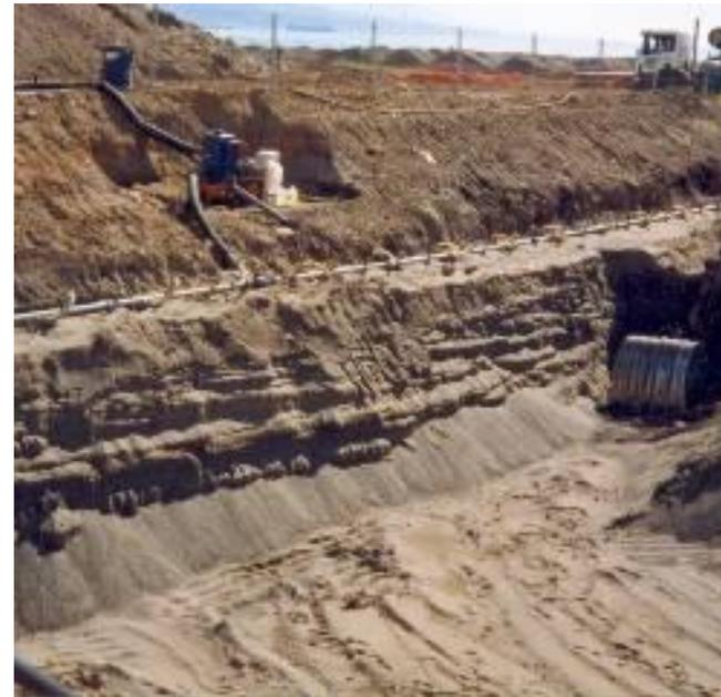
**Figura 3.12.-** Instalación de sistema wellpoint. Izda. Nivel freático inicial, previo al inicio del bombeo. Dcha. Nivel freático deprimido por la acción del bombeo (Málaga, 2006 - Cortesía de FERRER, S.L.).
