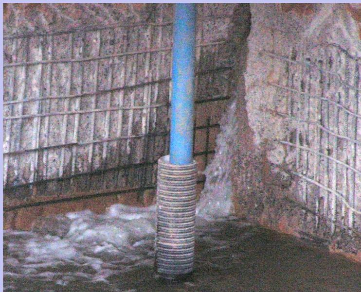
**Figura 2.22.-** Filtración lateral de agua a través de fallo de construcción de muro pantalla
