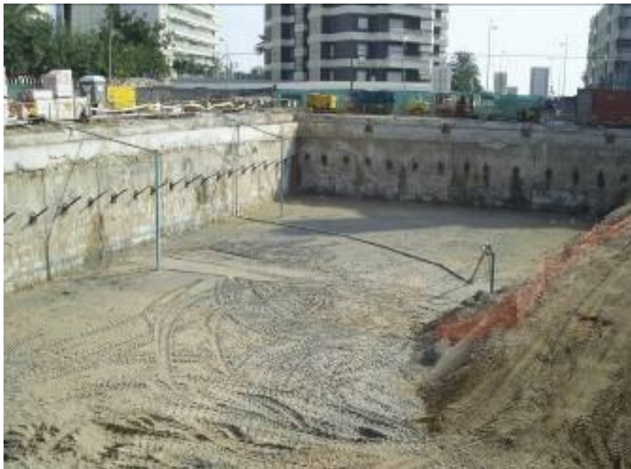
Figura 2.25.- Estado de la obra tras el sellado de las vías laterales, con el mismo sistema de drenaje funcionando que en la imagen anterior. Gandía – Valencia. (Cortesía de FERRER, S.L.).
