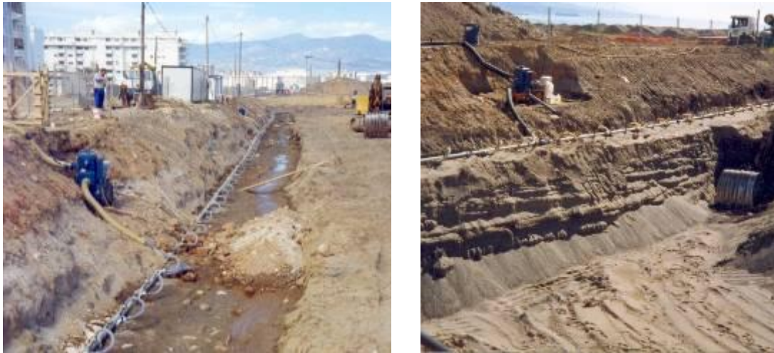
Figura 3.12.- Instalación de sistema wellpoint. Izda. Nivel freático inicial, previo al inicio del bombeo. Dcha. Nivel freático deprimido por la acción del bombeo (Málaga, 2006 - Cortesía de FERRER, S.L.).
