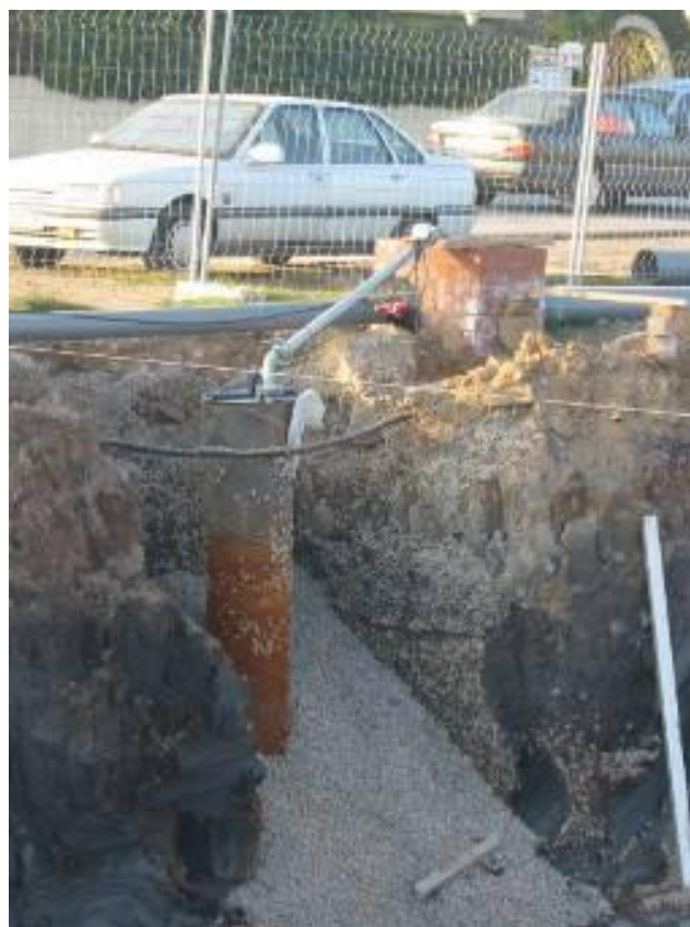
Figura 3.4.- Imagen de sumidero ( sump ) completamente equipado, tras la ejecución de la excavación (cortesía de FERRER, S.L.).
