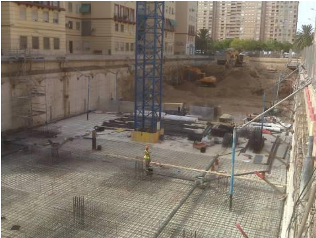
Figura 3.17.- Control de nivel freático con sistema de pozos profundos de baja capacidad. Valencia 2009 (Cortesía de FERRER, S.L.).
