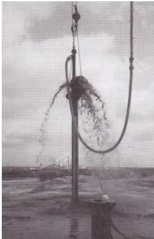
Figura 3.19.- Imagen de colocación de tubería para pozo de bombeo por inyección con tubería auxiliar interior (Cortesía de MORETRENCH).
