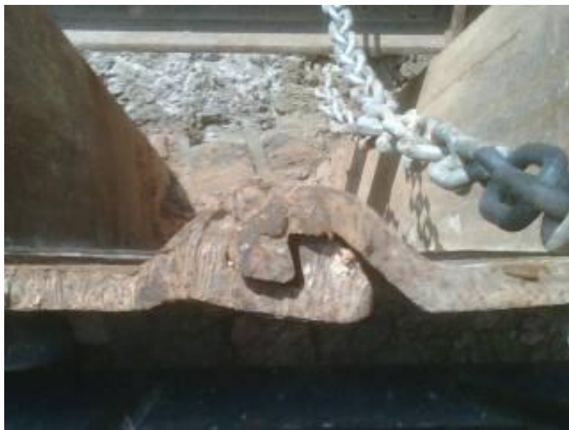
Figura 2.19.- Imagen de mordaza de unión del tipo simple (Cortesía de FERRER, S.L.).
