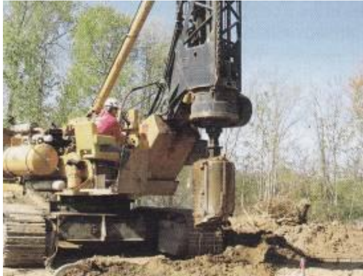
Figura 3.20.- Perforación con balde. (Powers et al. 2007).
